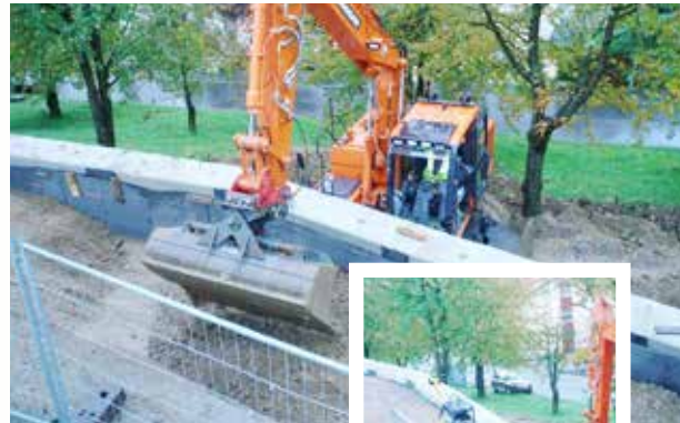
Verfüllen der Mauer
