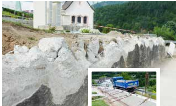
Rückbau der alten Mauer, versetzen und fixieren der neuen Mauer
