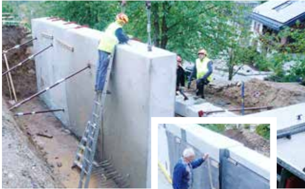
Versetzen der Fertigelemente, abdichten und legen der Drainage
