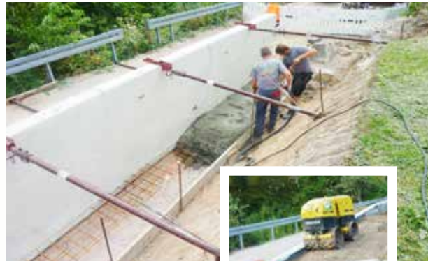
Betonieren, anschließend verfüllen und verdichten
